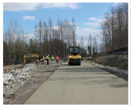
Der Walzbeton auf der 500 Meter langen Teststrecke in der Steiermark verbindet die Vorteile von Betonstraßen wie Langlebigkeit, Strapazierfähigkeit und geringe Wartungskosten mit dem raschen Einbau von Asphaltstraßen.
